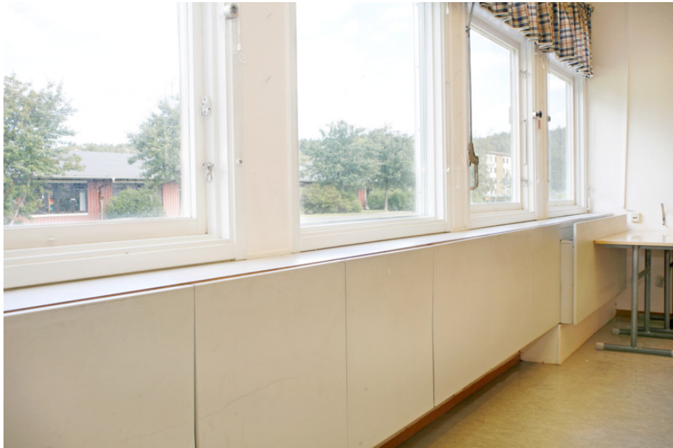
Klassrum före åtgärder: De gamla skolapparaterna som var avsedda att ge värme och ventilation hade slutat fungera
