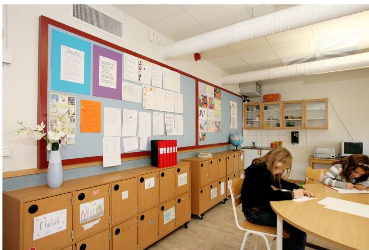
Diskbänken ersattes med förvaringsskåp. Ovanför dessa sattes ljudabsorberande, tygklädda anslagstavlor av polyesterfiber.
